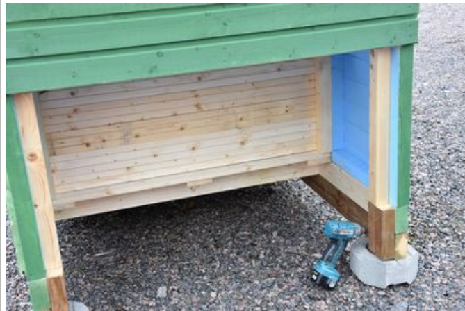
Pystyseinän kiinnitys sivuseinän keskijuoksuun ja istuinlevyn takatukipuiden asennus sivuseinän takajuoksuun 80 mm ruuveilla.
