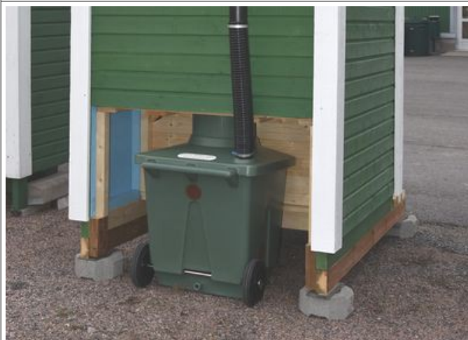
Green Toilet Familyn asennus.
