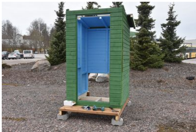
Loput seinät ja katon takalape. Takalappen sijainti niin, että takaräystääksi tulee noin 10 cm. Kiinnitys 80 mm ruuvein sivuseinien yläjuoksuihin.
