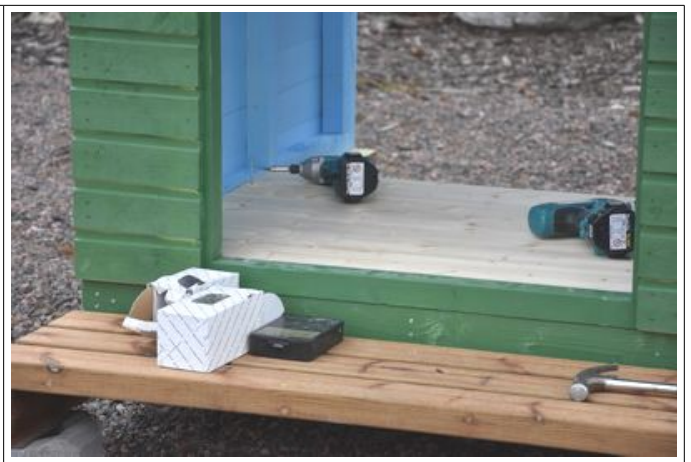
Lattian kiinnitys 80 mm ruuveilla.
