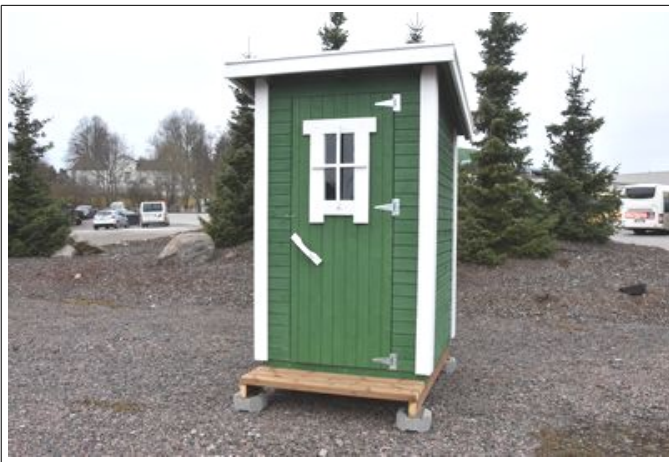
Oven ja verhouslautojen asennus 45 mm ruuveilla.
