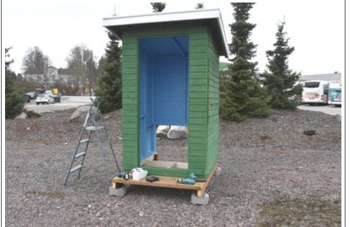
Etulape paikalleen etu- tai sivukautta nostamalla, varo rikkomasta huopakatetta. Räystäslautojen asennus ylempi lauta noin 10-12 mm yli alemman laudan. Kiinnitys 45 mm ruuveilla, poraa alkureiät lautoihin etteivät ne halkea.
